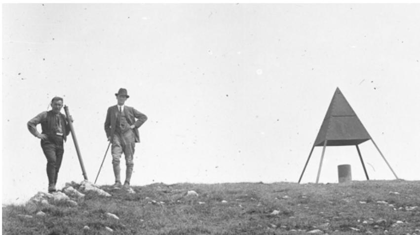
Topographes sur le Chasseral, 1921. La "pyramide" signale le point de triangulation.
